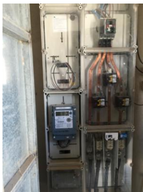
Figura 8. Comptador elèctric
