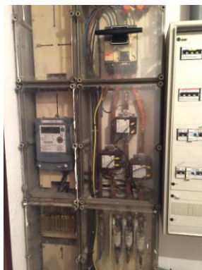
Figura 9. Comptador elèctric
