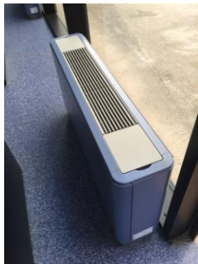
Figura 5. Unitat interior de climatització
